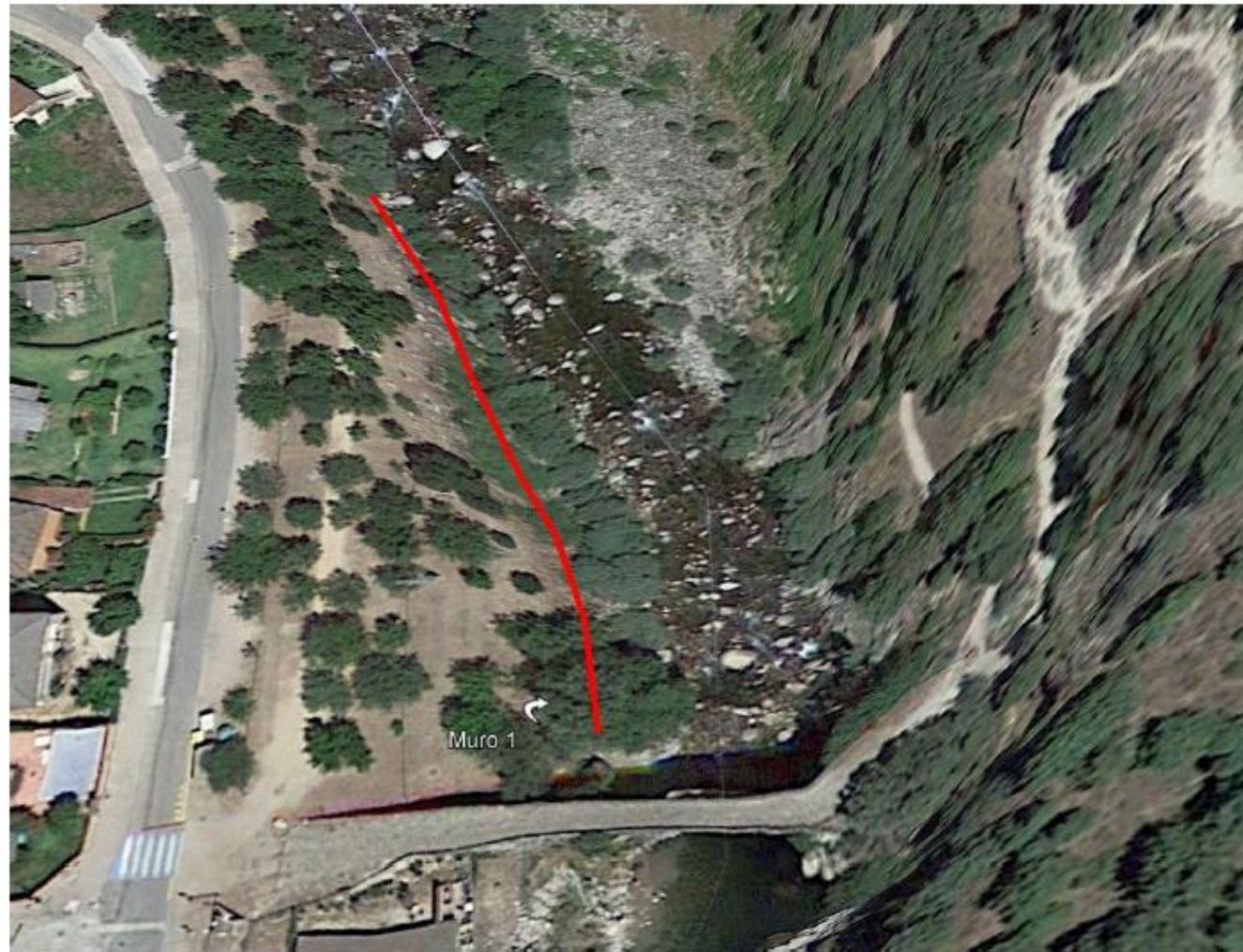
Vista general de la zona afectada
